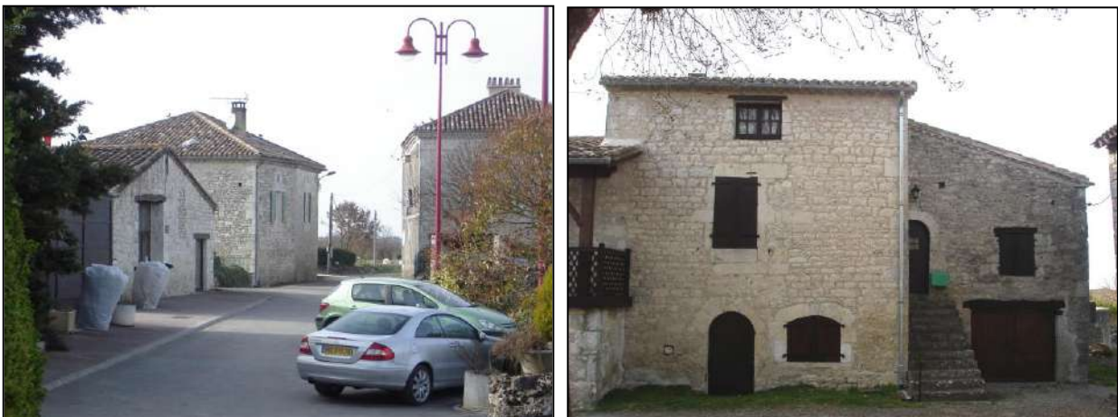
Bâti de caractère, revendicatif de l'identité quercynoise
